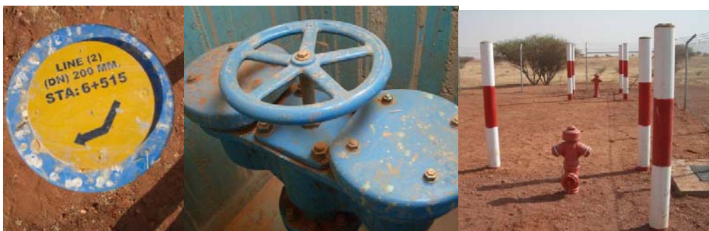
Leitungskennzeichnung (l), Entlüftungsventil (m), Hydranten (r)
